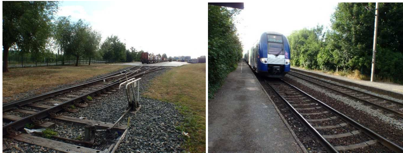
Figure 63 : Photographies des trains empruntant les voies ferrées (à droite la ligne principale – à gauche la desserte du centre de valorisation) – Source : Arcadis
