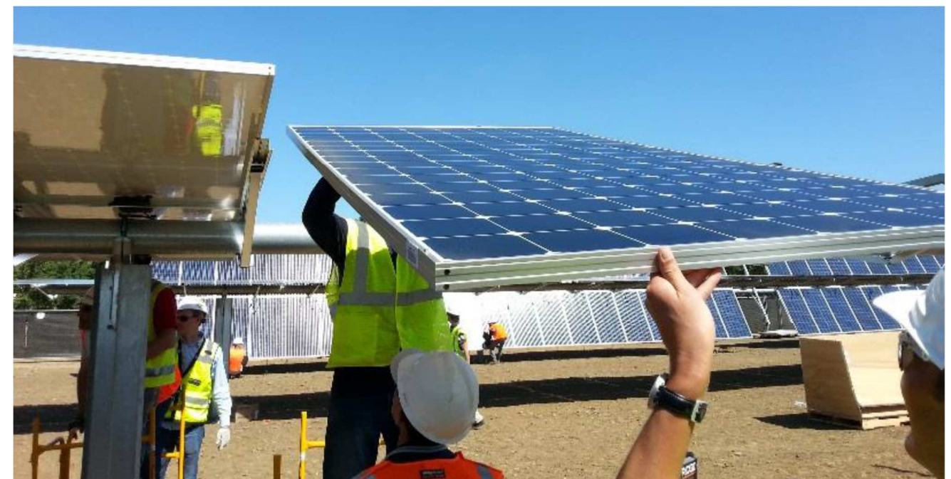
Figure 85 : Mise en place des panneaux photovoltaïques
